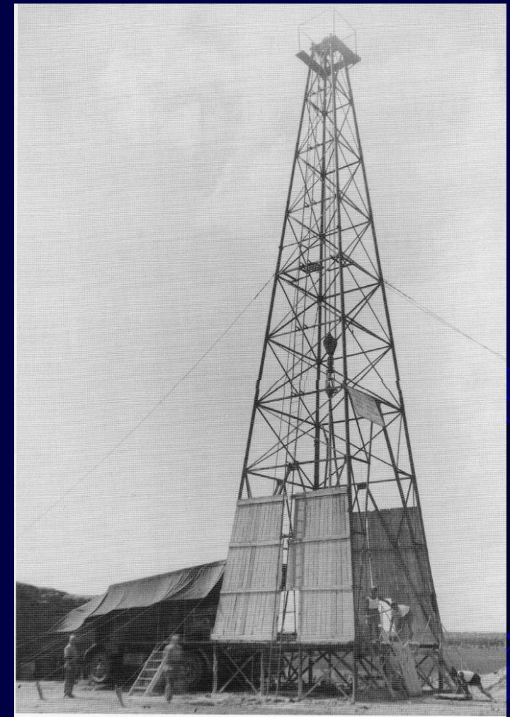
Fig. 77 - Impianto a rotazione a circolazione diretta di acqua per pozzi a carotaggio continuo tavoliere di Puglia
