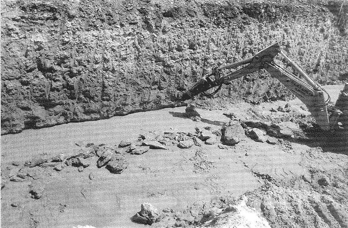
Fig. 4 - Depositi marini terrazzati affioranti in uno scavo a sud di Brindisi. Le acque freatiche sono localmente sostenute da un livello calcarenitico a consistenza lapidea.
